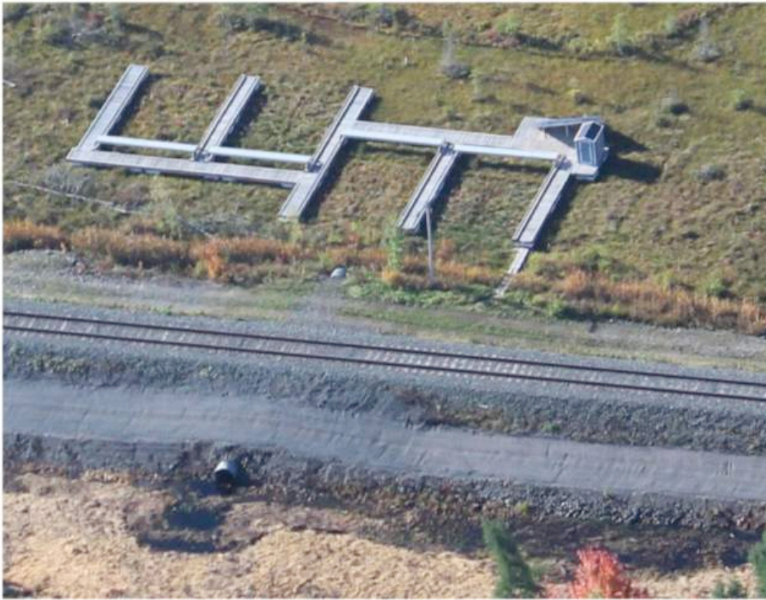
Plate-forme de décontamination du site du CN
